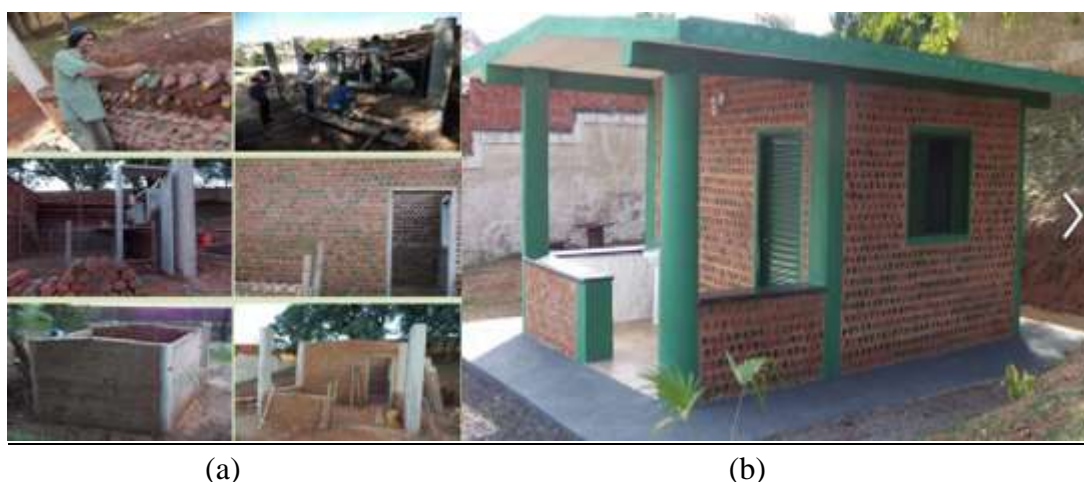
Figura 1. (a) Levantamento das paredes e muretas da Casa Pet. (b) Casa Pet finalizada. Fonte: Manual de construção da Casa Pet
