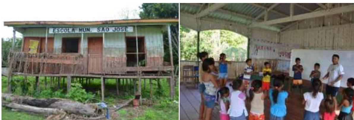
Figura 2 . Escola desativada na comunidade Sítio Fortaleza – Uarini/AM. Foto: Eliane Neves. Data: Nov. 2015. Figura 3. Centro comunitário sendo utilizado como escola improvisada na comunidade Sítio Fortaleza – Uarini/AM. Foto: Eliane Neves. Data: Nov. 2015.
