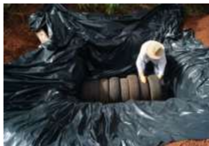
Figura III – Impermeabilização com lona plástica e preparo dos pneus.
