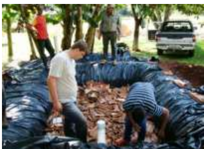
Figura V – Preenchimento com entulho de construção
