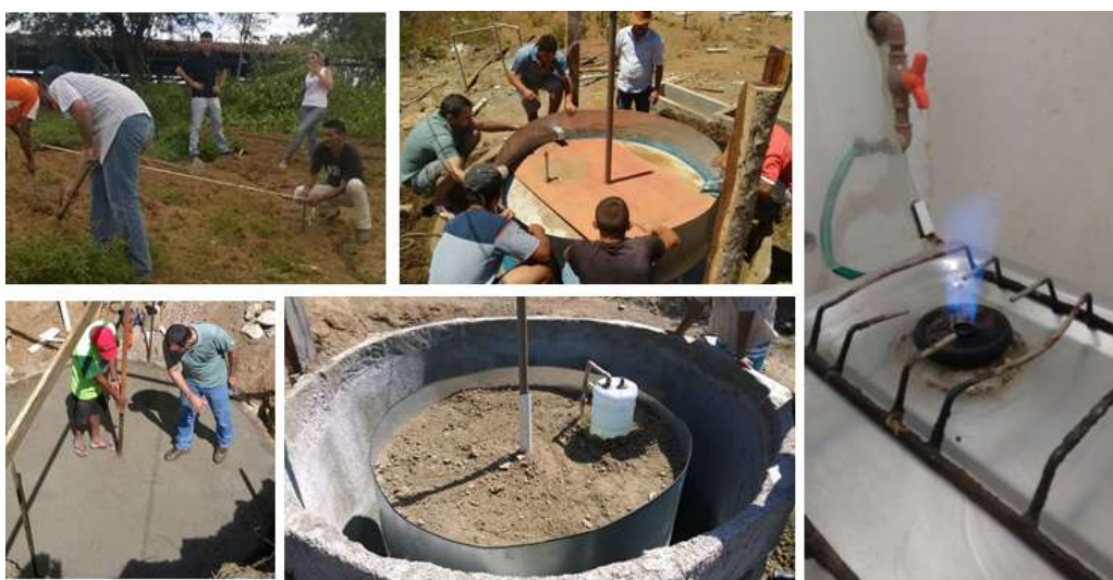
Figura 06 – Etapas de construção e instalação do Biodigestor. (Fonte: autoria própria)
