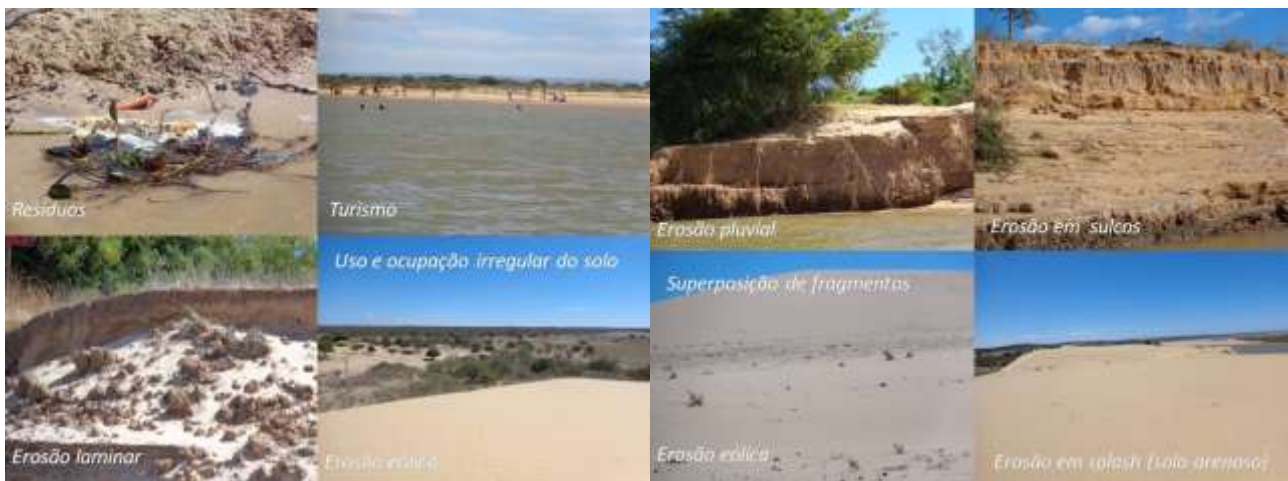
Figuras 9 - 16 - Impactos encontrados in loco Fonte: Pacheco (2014)
