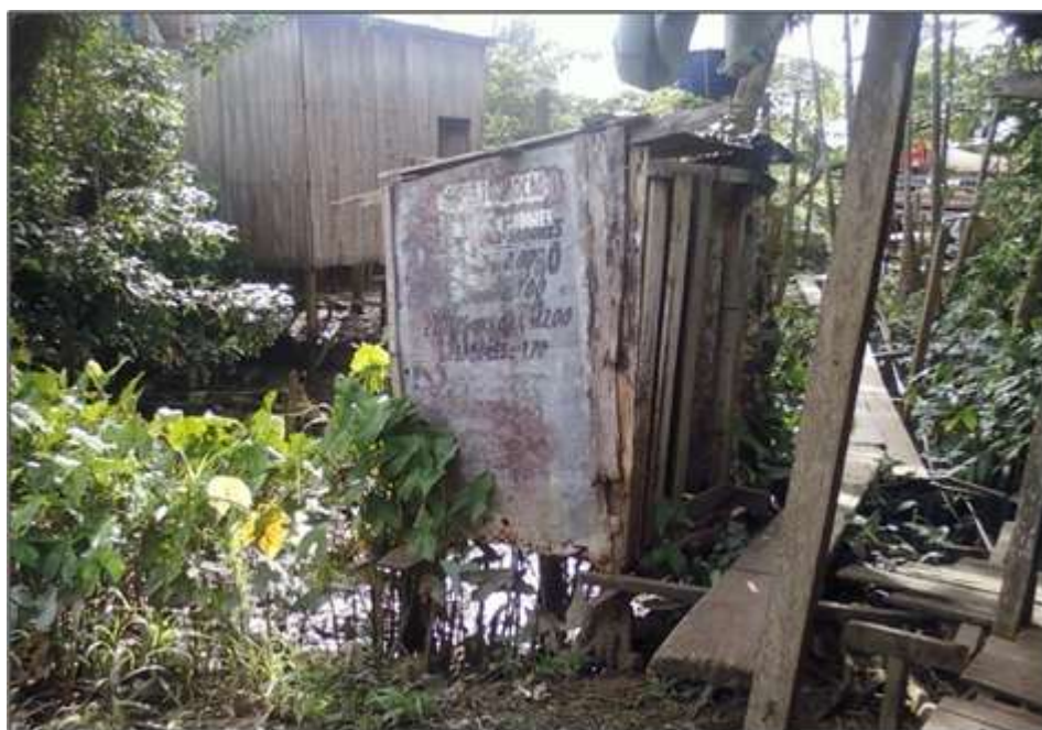
Figura 2: Sanitário construído no leito do igarapé Mata Fome. Fonte: SILVA, 2015.
